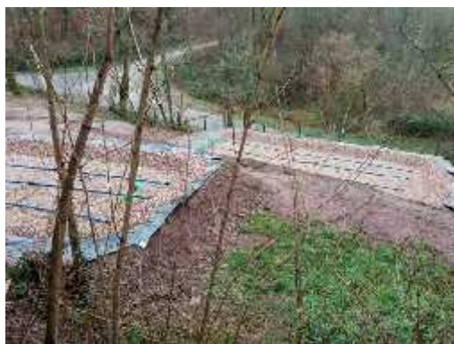
Neue zweistufige Kläranlage auf dem unteren Geländeteil
